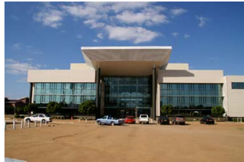
写真 4. 竣工まもない経営学部建物
