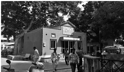
写真1 アルワールにあるスラブの公衆トイレ
