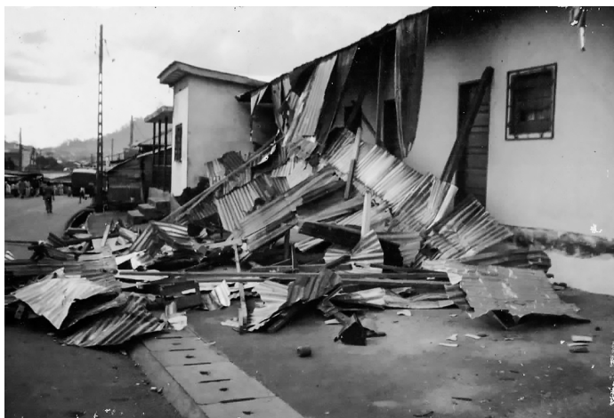
写真 1 破壊された「スンニー・モスク」
