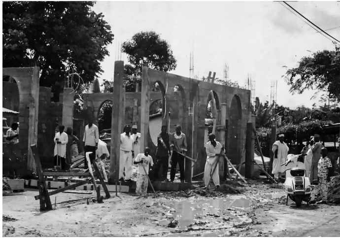
写真2 建設中のンコルビソン・モスク
