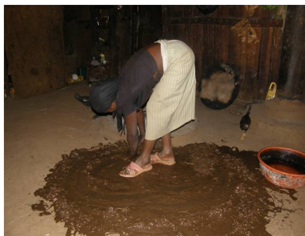
図 2. 糞を家の補修材として用いている様子
