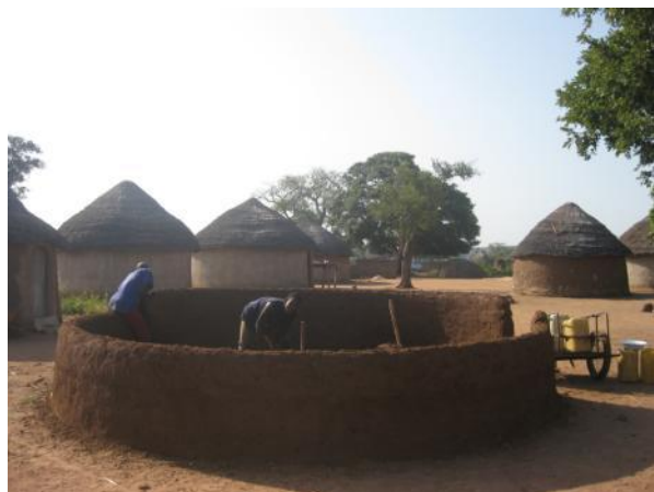
写真④：調査地にて新しく建設中の家。調査地の家は土づくりである。（カメルーン北部）
