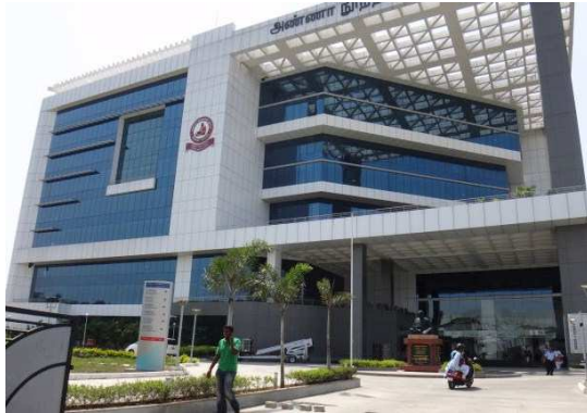
写真5 アンナ中央図書館
